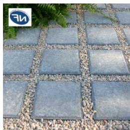
Ci-contre, illustration de la surface des espaces d'entrée de lot : Mise en œuvre de pavés drainant
